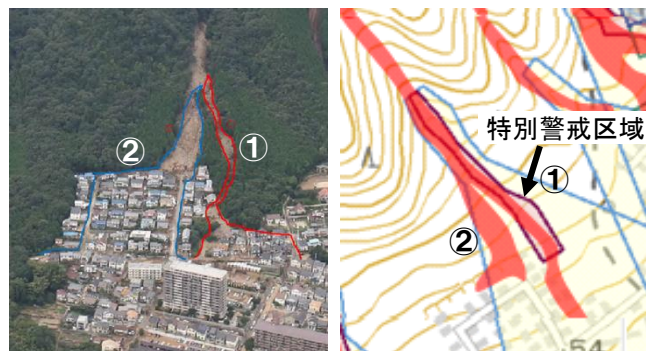
阿武の里団地の被害状況 警戒区域図＋土砂流出図 図 4 土砂災害警戒区域図との比較例（阿武の里団地）
