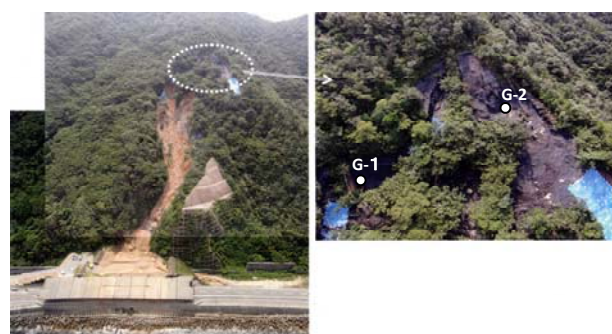
(a) 計測現場の全景
