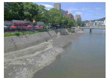
写真-2 大規模施工後
