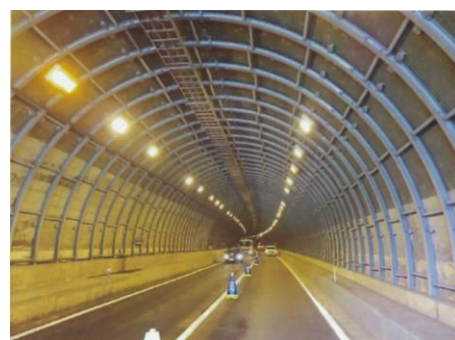
写真-1 A トンネル内の対策工の様子
