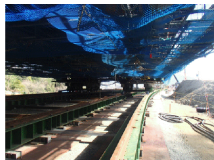
写真-1 軌条設備の設置状況
