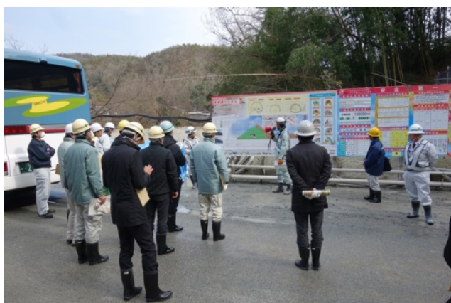
入坑前の工事概況説明（岡山県庁担当）
