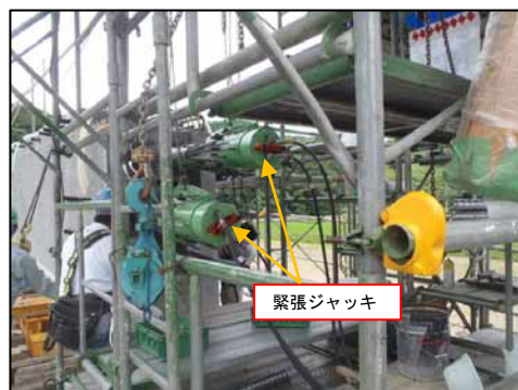
写真-2 緊張装置2組による緊張状況
