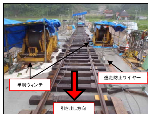
写真-3 主桁引き出し装置設置状況
