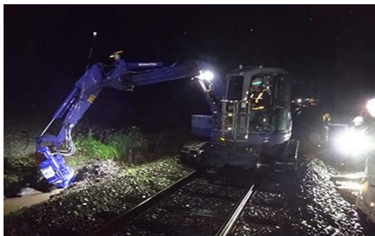
写真-2 新型アタッチメントによる施工風景
