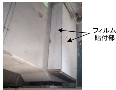
写真-3 封かん養生状況
