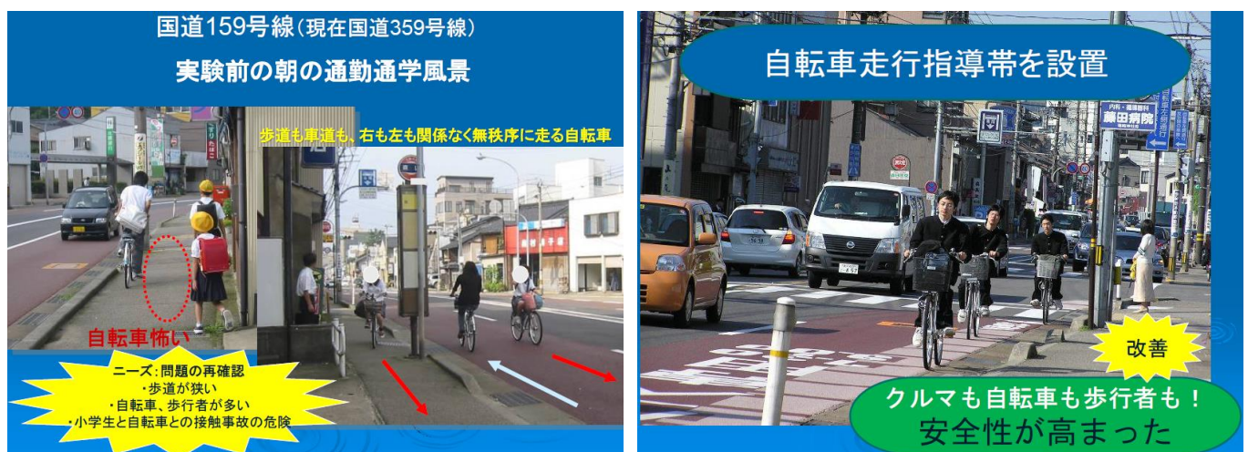
金沢市における道路空間再配分による自転車走行空間整備
