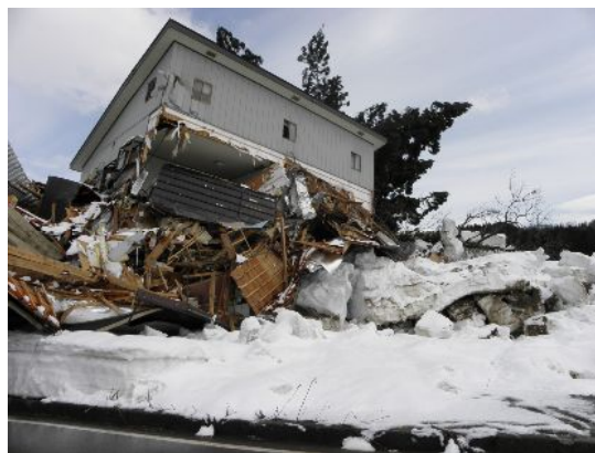
写真-2 地すべり末端部
