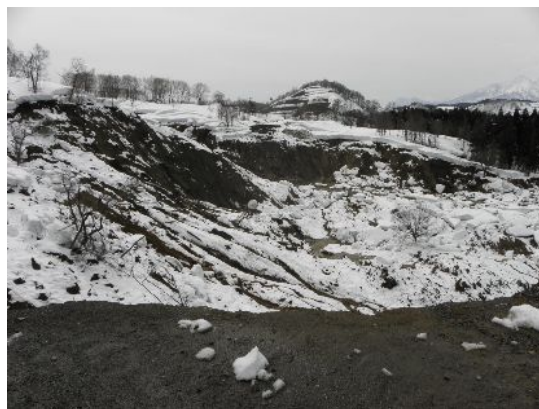
写真-1 地すべり頭部
