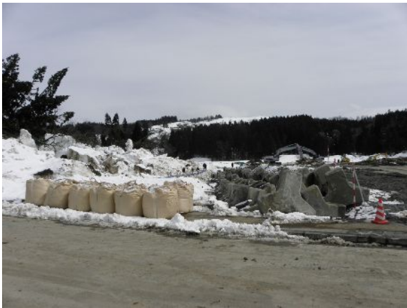
写真-3 応急対策工事状況
