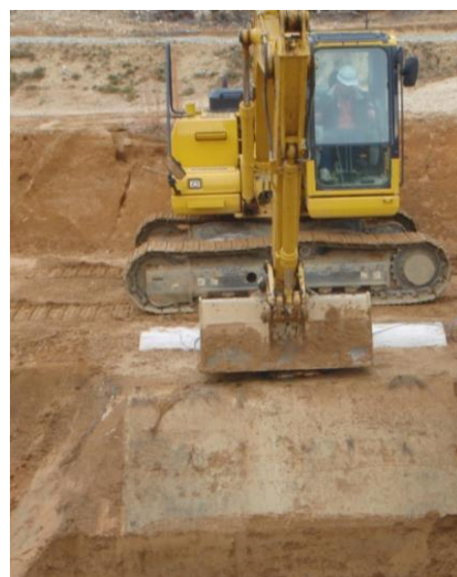
写真-2 堤体への载荷状況
