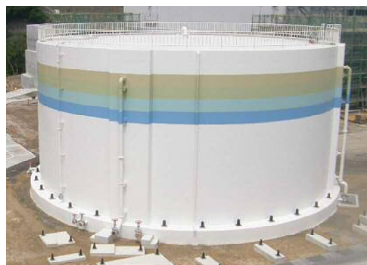
写真-1 PC タンク完成状況
