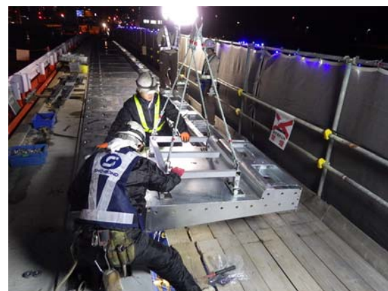
写真-3. 架設状況②（ショボンド建設㈱提供）
