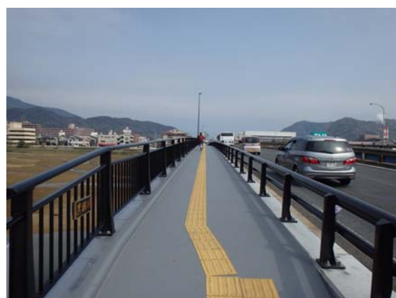
写真-4. 工事完成後
