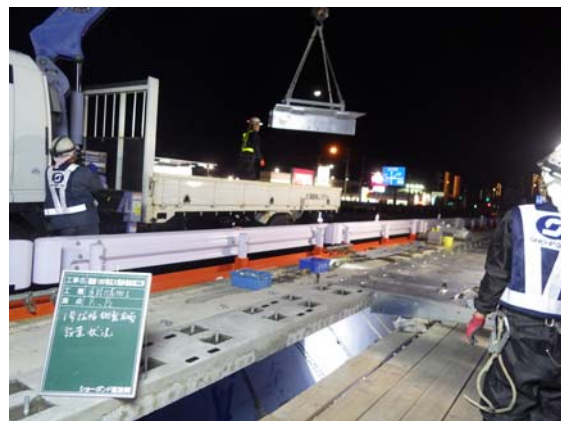
写真-2. 架設状況①（ショボンド建設㈱提供）
