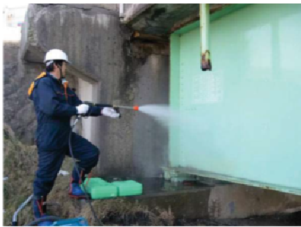
図1 桁洗浄の作業状況
