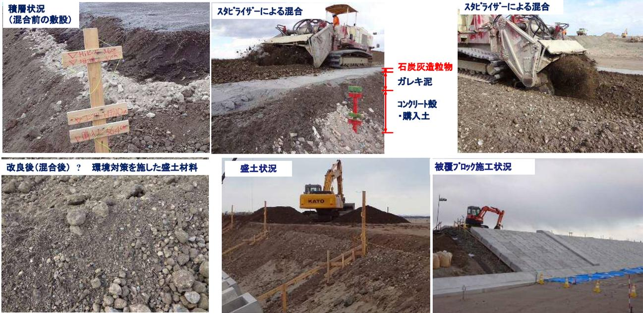
図-8 石炭灰造粒物を混合したガレキ泥による海岸堤防 (施工状況)
