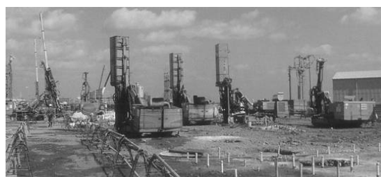
写真－3 地盤改良工状況
