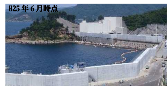
写真－6 1,2 号機北側津波防波壁全景写真
