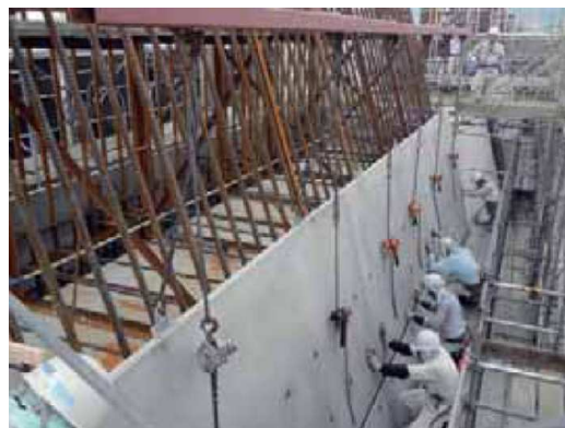
写真-2 プレキャストコンクリート型枠据付状況
