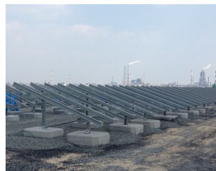
太陽光発電所基礎ブロック
