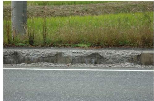
写真-1 凍害の生じた道路縁石ブロック
