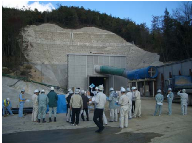
トンネル坑口の状況観察
