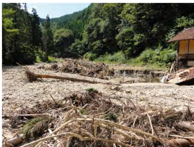
写真 5 清見町における土石流
