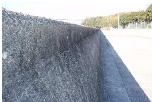
写真 4 東部浄化センター護岸 (平成 26 年 1 月撮影)
