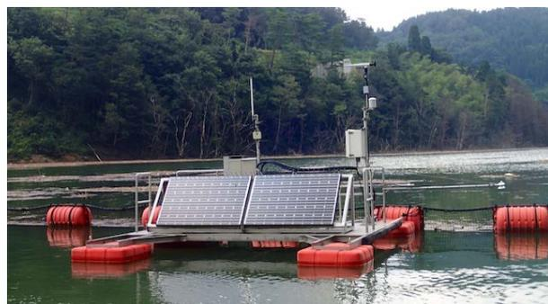
図-2 殿ダム貯水池の気象観測装置
