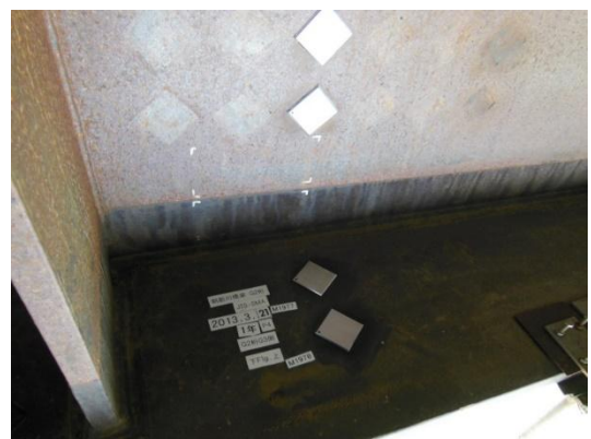
写真1 朝酌川橋梁の曝露試験概要
