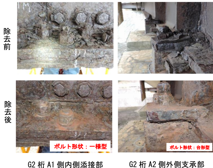
図5 高力ボルト及びアンカーボルトの状態
