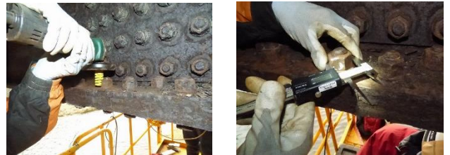
写真 2 添接部の高力ボルト調査状況
