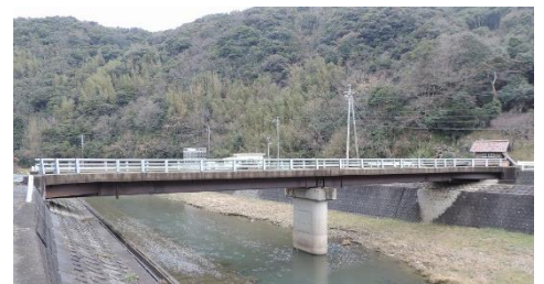
写真 1 対象橋梁の上流側
