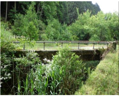
写真-1 “水無橋”の現況
