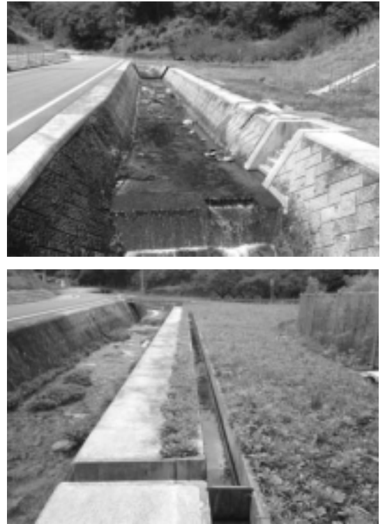
図 - 1 調査地の状況（河内川）
