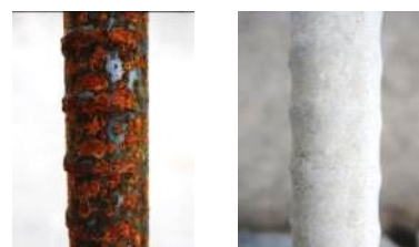
(a) 接着剤無 (b) 接着剤有 写真-3 鉄筋の腐食状況(暴露 136 日目)
