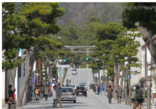
写真4 完成した神門通りの状況（全景）
