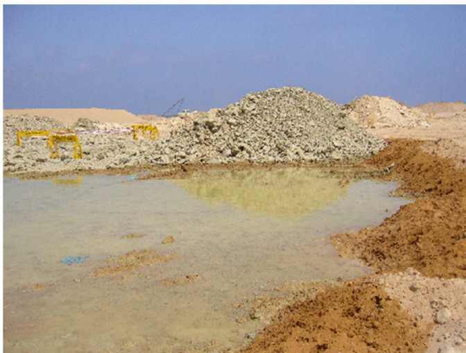
写真1 滲出した地下水
