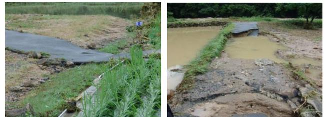
図-1 洪水氾濫による道路盛土の損傷事例(広島県三條川流域 2010/7/14 撮影)
