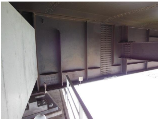
写真 1 朝酌川橋梁の桁内鋼板の状態
