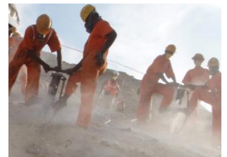
(b) 岩掘削現場
