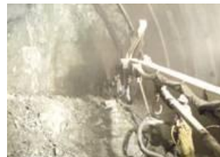
(a) 吹付けコンクリート施工現場
