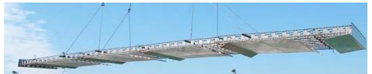
写真 - 1 鉄筋付鋼製型枠床版
