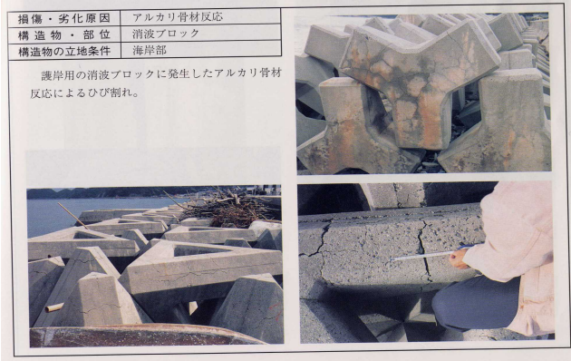
写真 1 アルカリ骨材反応の実態
