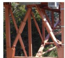
写真 2 制振ブレース材
