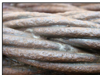
(2) 隙間部の当初メッキの残存 写真-2 メインケーブル
