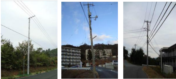
(a)グループ A (b)グループ B (c)グループ C 写真-1 各グループの電柱の例
