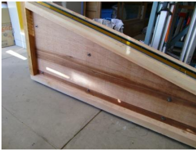
写真 5. 袖部コンクリート用型枠
