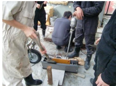
写真 10. コンクリート打設の様子
