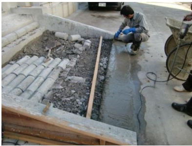
写真 7. スロープ部のコンクリート打設の様子
