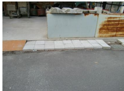
写真 12. コンクリート製品の設置例
