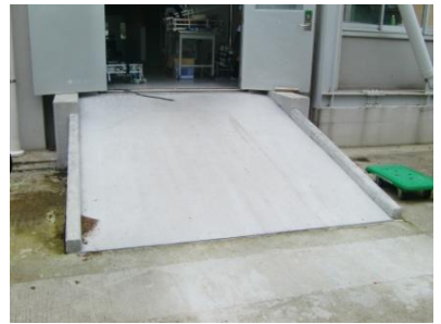
写真 8. モルタルによる表面仕上げ
