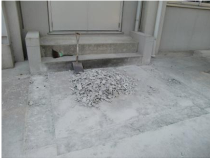
写真 2. スロープ設置前
