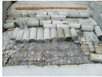
写真 6. 基礎地盤整形・鉄筋組み
