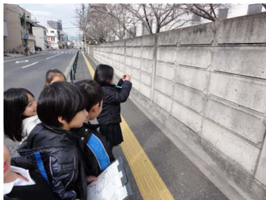
写真1 現地調査ーブロックベいの観察
