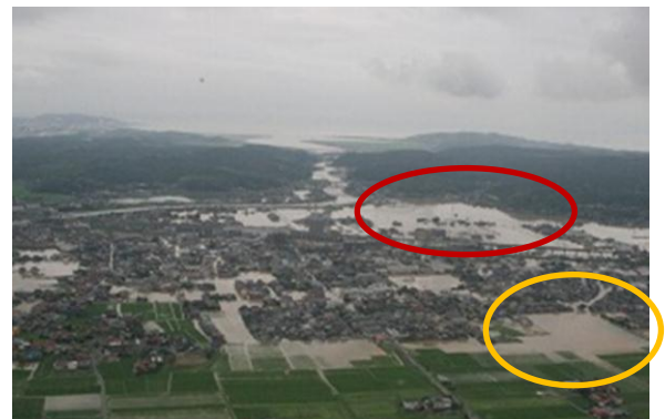
図10 厚狭地区の洪水被害の様子 8)
