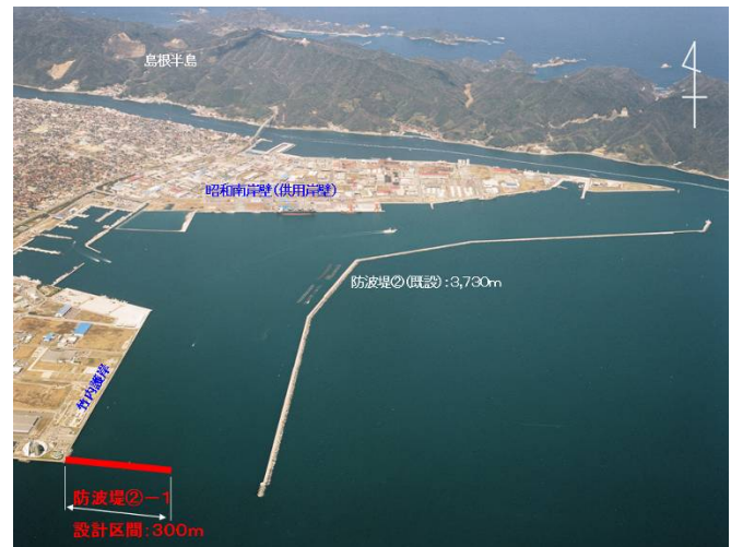
写真-1 境港湾内の現況 (H18.5 撮影)
