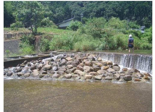
図1 粗石付き斜路と階段式魚道
