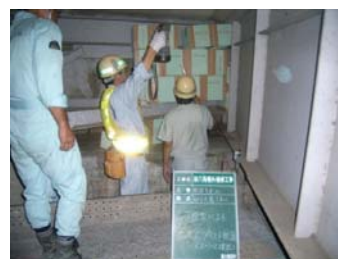
写真-4. 現場検討状況
