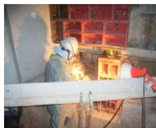
写真-5. 施工状況
