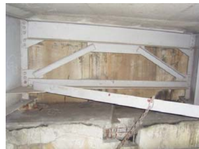
写真－2. 施工現場状況
