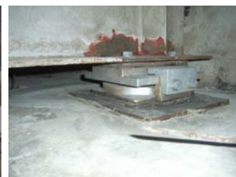
写真-6. 交換後の沓座
