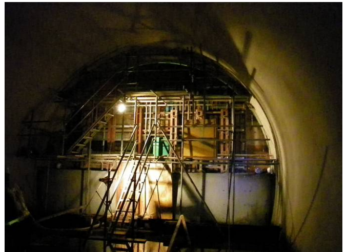
写真 5-2 上流型枠完成写真
