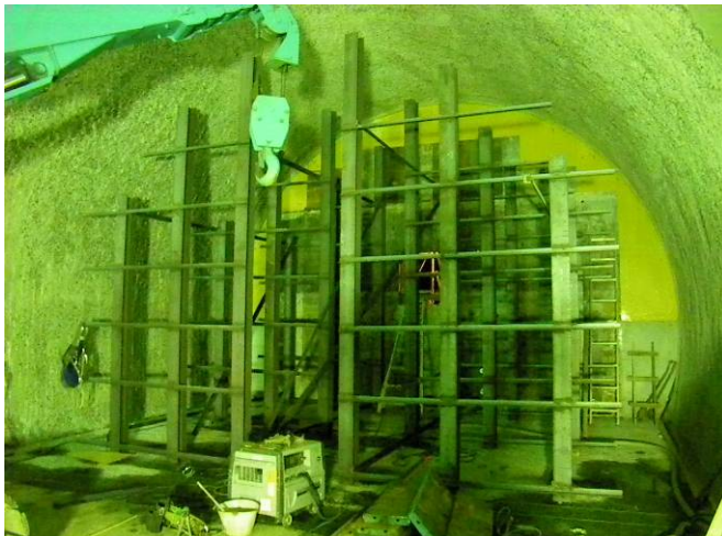
写真 5-1 型枠補強兼用打設足場（仮閉塞工内部）
