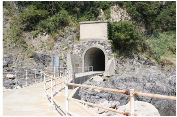
図-4 トンネル出口（補修後）
