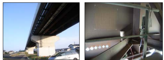
写真1 A橋の曝露試験状況
