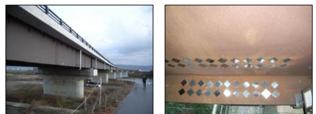
写真2 B橋の曝露試験状況
