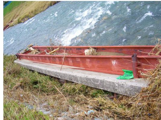
Photo 1 兵庫県佐用郡・宍粟市 H21.8.9 豪雨による流橋被害事例<sup>1)</sup>
