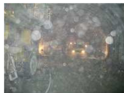
写真 - 2 トンネル坑内の撮影
