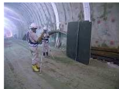
写真 - 3 デジタルカメラを用いた粉じん濃度計測風景
